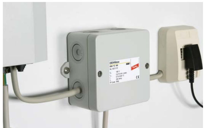
Schutz einer Telekommunikationsschnittstelle (Telefonanschluss) am Gebäude-eintritt
