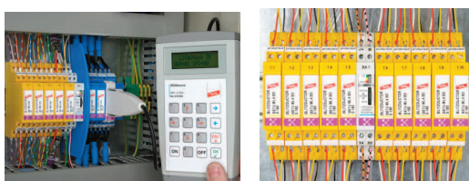
Рис. 2. Переносной тестер DRC LC M3+ и стационарный блок мониторинга DRC MCM XT для контроля состояния до 10 сменных модулей УЗИП BLITZDUCTOR® XT
