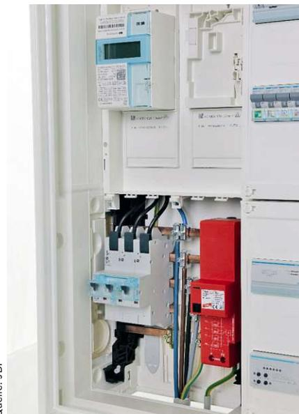
**Bild 1:** Ausführung einer SPD im unteren Anschlussraum des Zählerschranks
