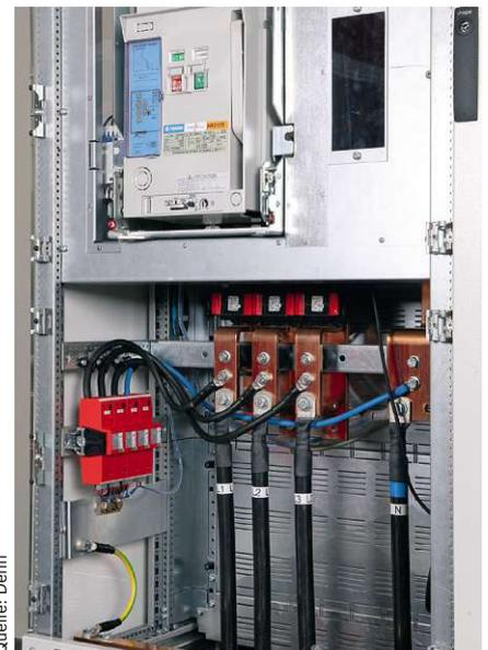
**Bild 2:** Typ-1-SPD »DehnvenCI« mit integrierter Vorsicherung im Einspeisefeld einer NSHV
