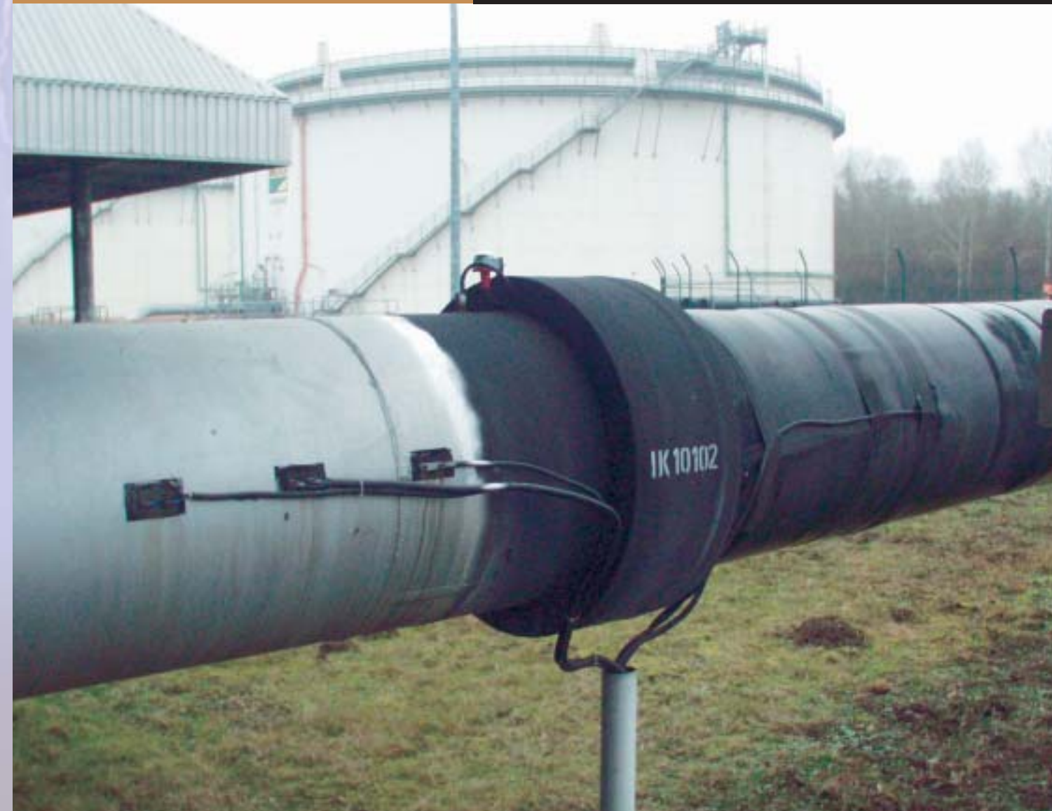
4 EXFS L100 Art.-Nr. 923 060 ATEX-zertifizierte Funkenstrecke zum Einsatz in Ex-Bereichen (Zone 2) zum Schutz vor Überspannungen und Blitzströmen ATEX certified spark gap for use in hazardous areas (zone 2) for protection against overvoltages and lightning currents
