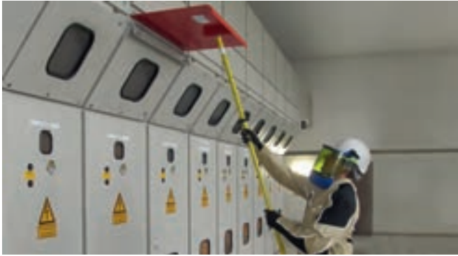
通过操作棒插入绝缘防护挡板（A3型）
