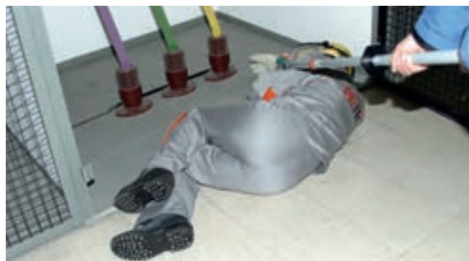
利用绝缘的RST救援杆，从带电工作区内抢救触电受害者
