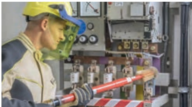
使用TRS NS 干洗套件对低压开关柜进行带电清洁
