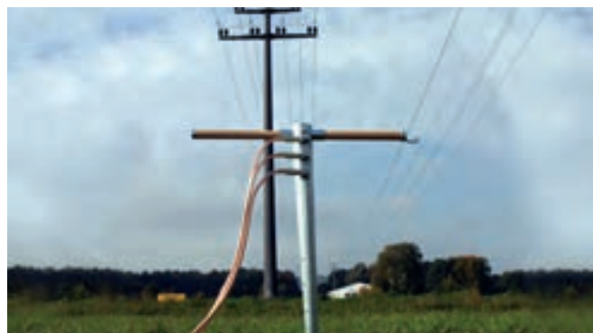
固定在一个管状接地极上的接地排和接地线
