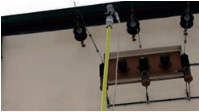
带铝制锥形接口和单螺旋夹具的可伸缩接地棒
