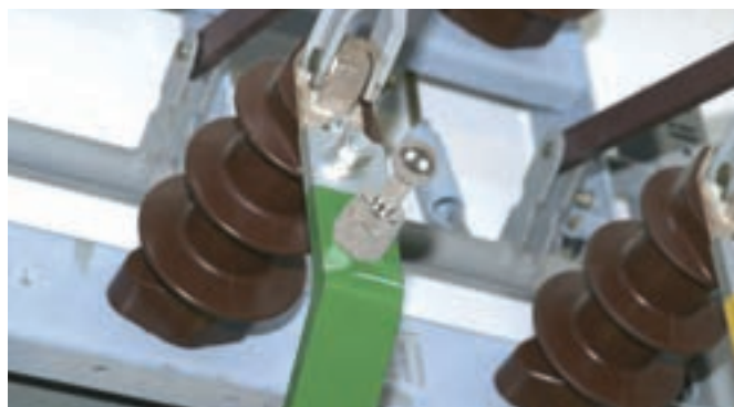
安装在母排上的直线型固定球
