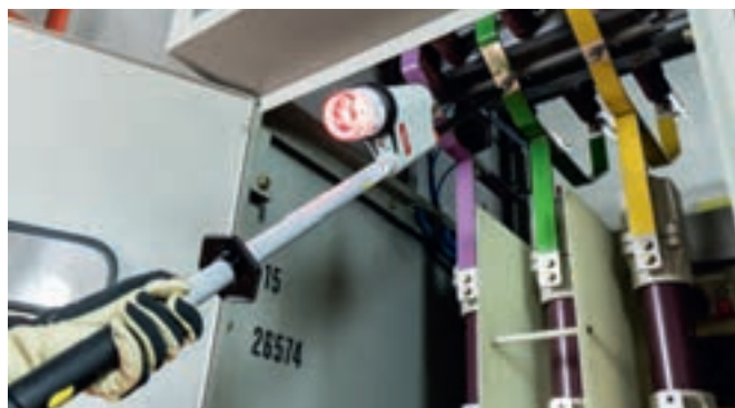
PHE4电压探测器带声光指示
