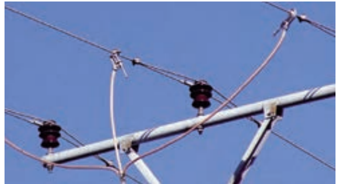
相线螺栓夹具使用在架空线
