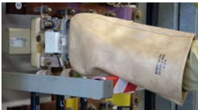
使用带有袖套的NH熔丝手柄取放NH熔丝
