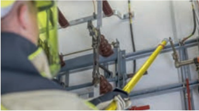
通过SCS开关棒开关一个断路器
