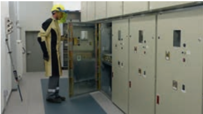
电控室地板用，绝缘垫50 kV
