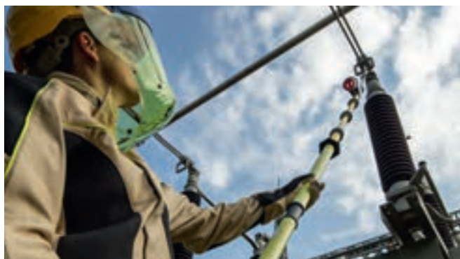
PHE4电压探测器应用在110 kV户外开关设备
