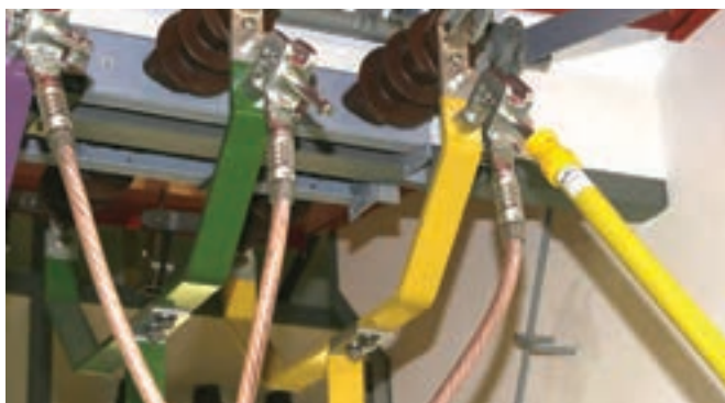
采用接地棒，使设备接地或短路
