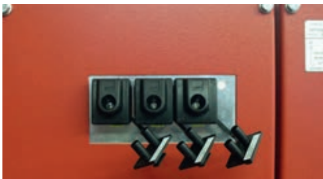
无源 DEHNcap / P电压指示器，用于封闭的开关设备中
