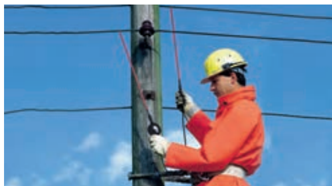
两极SPN电压探测器配合延长探针使用, 适用于架空线路
