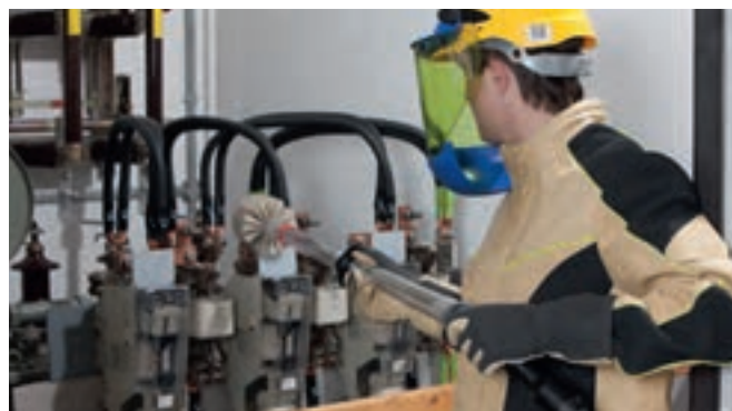
在带电环境下，使用TRF MS 组合件对变压器进行清洁处理
