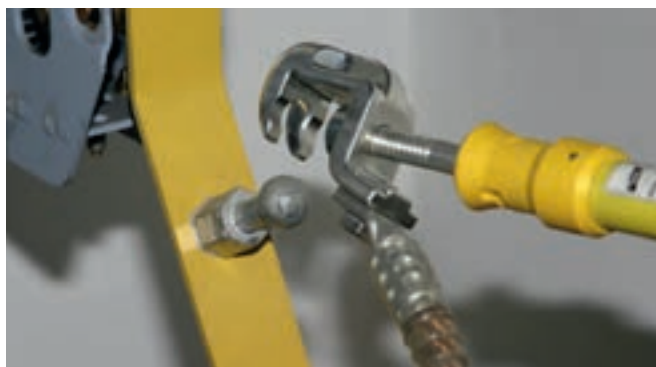
利用通用夹具连接到相线母排上的固定球头
