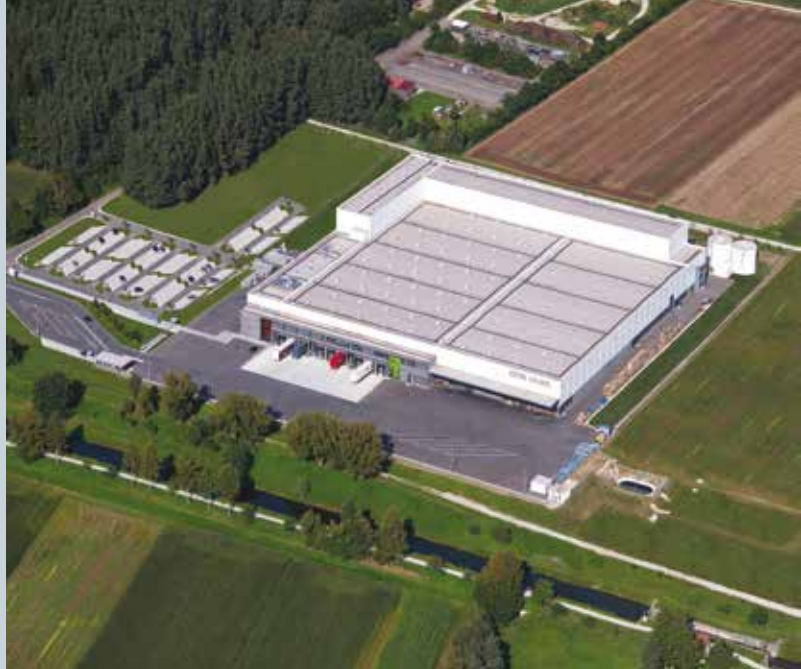
Site logistique et de préfabrication à Mühlhausen - Allemagne
