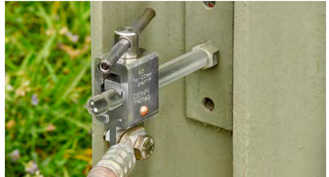
Erdanschlussbuchse mit Schraubknebel an einem Erdungsfestpunkt mit Ringnut.
