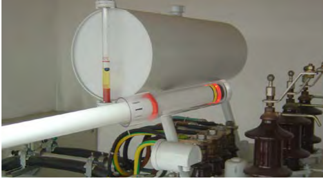
Hochspannungsanzeiger HSA 205 mit aufgesteckter Isolierkappe an einer Schaltanlage.
