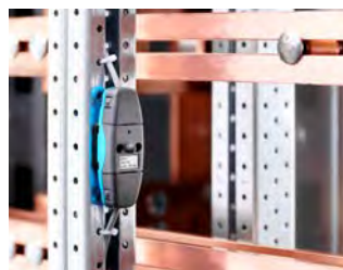
Eingebaute Lichtsensoren
