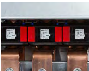
Eingebaute Schutzstromwandler
