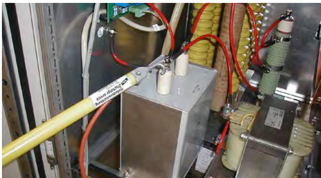
Einpolige Entladevorrichtung zum Ableiten statischer Ladungen.
