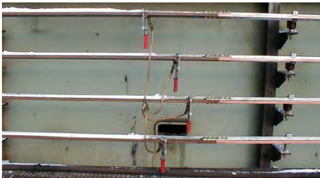
Dreipolige Erdungs- und KurzschlieÙvorrichtung mit Zwingenklemmen.
