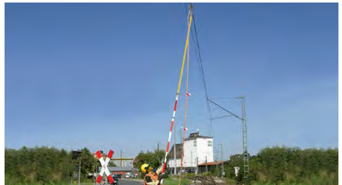
Einhängen einer Bahnerdungsvorrichtung.
