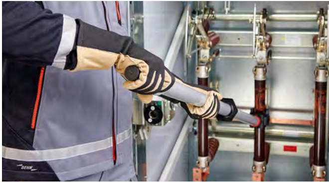
Betätigung eines NH-Aufsteckgriffes mit dem Schutzhandschuh.
