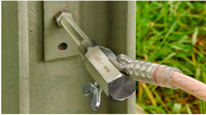
Erdungsfestpunkt mit Ringnut und Erdanschlussbuchse.
