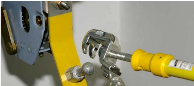
Montage einer E+K-Vorrichtung mit Uniklemme fr Kugelfestpunkte 20 oder 25 mm
