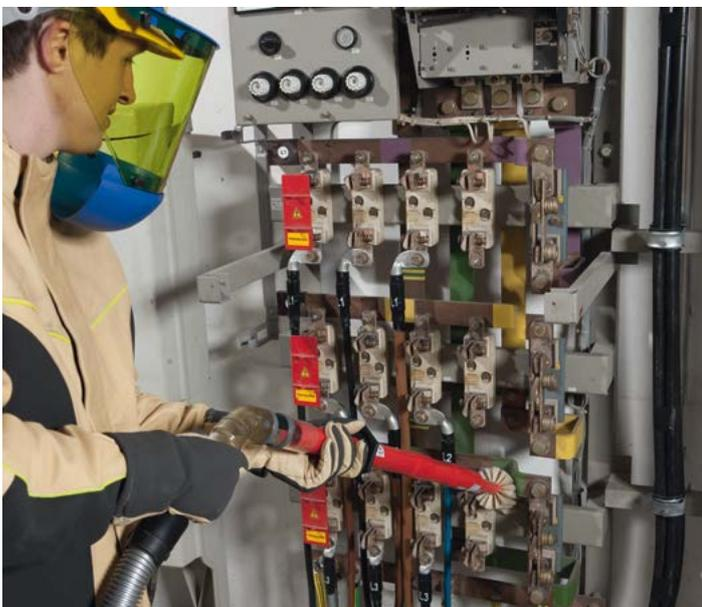
Reinigung eines Niederspannungs-Schaltgerütes
