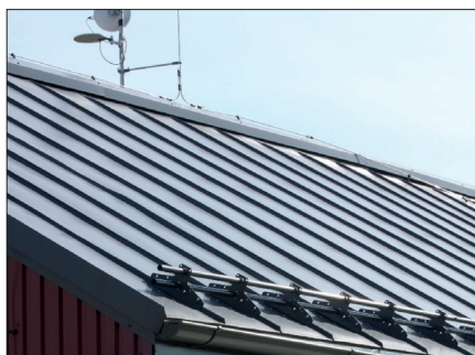
Obr. 3. Instalace běžného hromosvodu na plechové střeše
