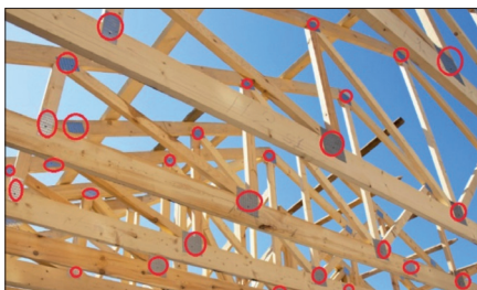
Obr. 2. Kovové prvky střešní konstrukce
