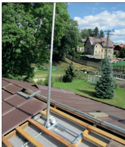
Obr. 8. Skrytý svod uložený ve střešní konstrukci
