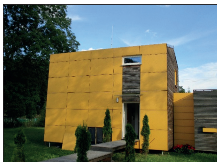
Obr. 7. Izolovaný hromosvod na rodinném domě (foto: Aleš Bubeníček)
