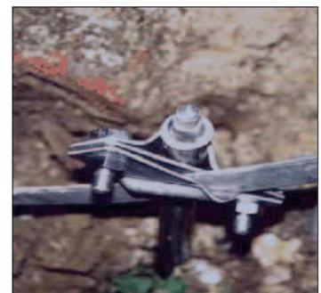
Figura 5: Instalación de puesta a tierra.
