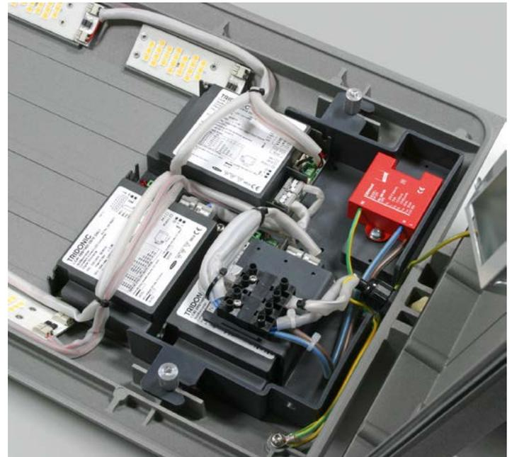
DEHNcord passt durch die kompakte Bauform mit geringen Abmessungen auch in kleinste Installationsräume. Das Foto zeigt die Verwendung in einer LED-Straßenleuchte.
