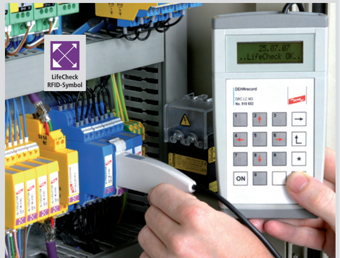
Kontrola ogranicznika przepięć z modułem RFID (LifeCheck)
