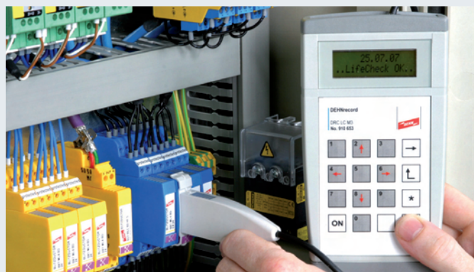
Kontrola modułu ogranicznika ze znacznikiem RFID
