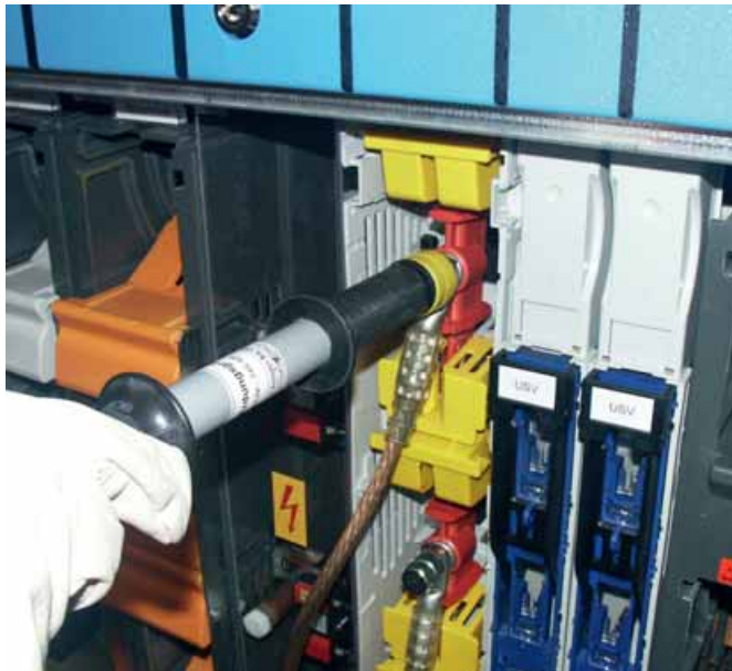
Részben szigetelt földelő- és rövidre záró eszköz csatlakoztatása TI típusú kezelőrud segítségével
