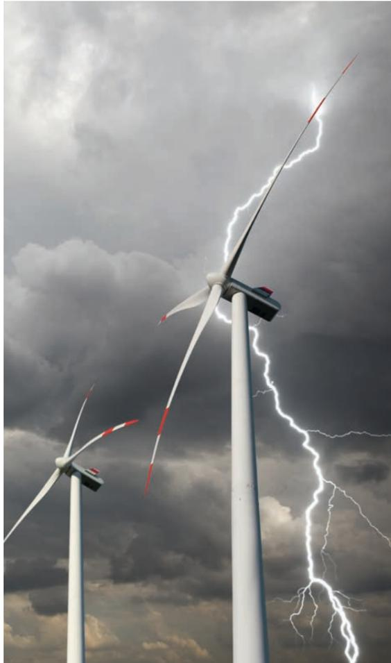
Windenergieanlagen sind aufgrund ihrer Höhe zerstörerischen Blitzereignissen besonders ausgesetzt. Daher ist ein durchgängiges Blitzschutzsystem, bestehend aus äußerem und innerem Blitzschutz, Erdung und Potentialausgleich, unabdingbar. Nur so lassen sich blitzbedingter Anlagenstillstand und damit verbundene Ausfall- und Instandhaltungskosten stark reduzieren.
