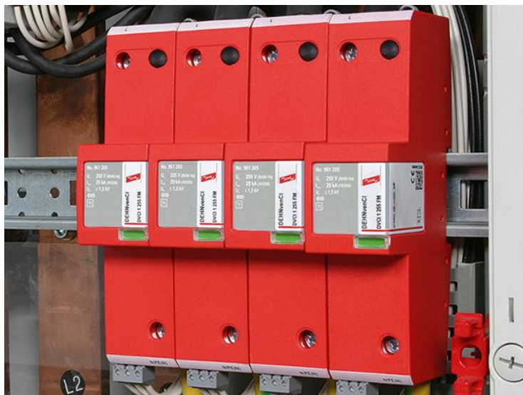
12. ábra: DEHNvenCI 1.+2.(+3.) típusú, előtét-biztosítással rendelkező kombinált villámáram-levetető bekötése és alkalmazási példája
