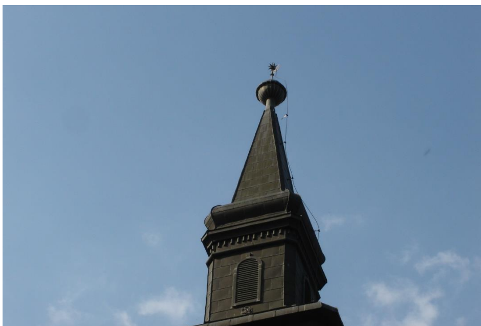
1. ábra: Kérdés a villámvédelmi levezetők kialakítása a templomtorony tetején
