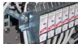
Montážní sada (montážní lišta, distanční sloupky) jako příslušenství pro instalaci do 19" skříně.
