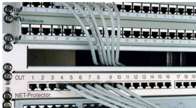
Vestavné pouzdro šířky 482,6 mm (19") osazené deskami plošných spojů se svodiči přepětí chrání síťové komponenty (třída D) nebo telekomunikační zařízení.
