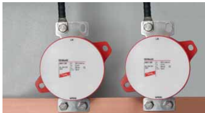
Chrání zařízení a spotřebiče před přepětím i při přímých úderech blesku. Instalace na rozhraní zón ochrany před bleskem LPZ 0 A – 1.
