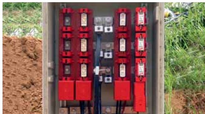
Chrání nízkonapěťová zařízení před přepětím. Instalace na rozhraní zón ochrany před bleskem LPZ 0 B – 1 a vyšších. DE-Patent.
