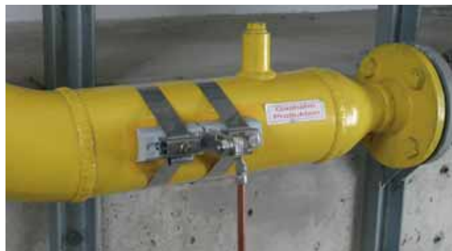
Svorka pro zajištění elektrického kontaktu potrubí v prostředí Ex, pro potenciálové vyrovnání při působení blesku podle ČSN EN 62305-3 ed 2.
