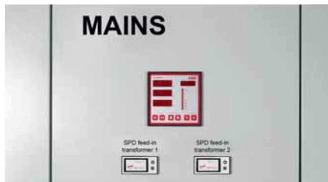
Optická signalizace svodičů přepětí pro umístění do dveří rozváděče.
