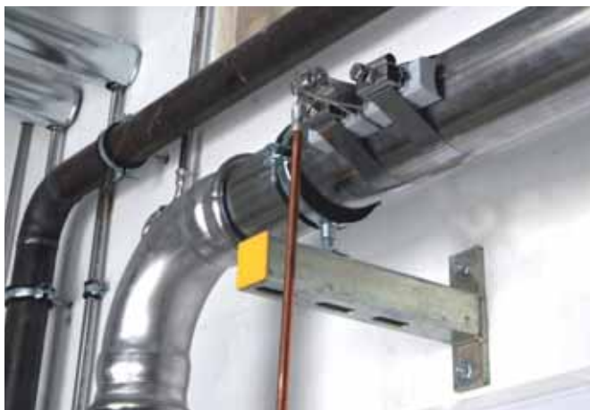
Instalace na ocelovém potrubí
