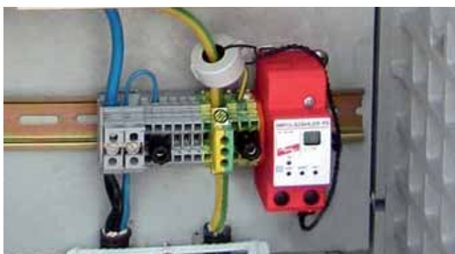
Čítač impulzů s vestavěnou baterií pro napájení (9 V) a kontrolou stavu baterie. Dvoumístný LCD displej s tlačítky nastavení a vynulování.
