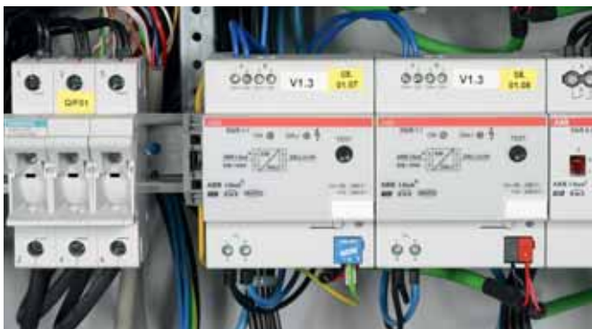
Svodič přepětí s přípojovacími vodiči pro sběrnice KNX/EIB.
