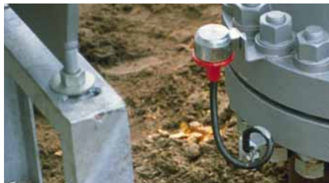
Oddělovací jiskřiště s certifikací ATEX a IECEx pro vyrovnání potenciálů v ochraně před bleskem podle ČSN EN 62305, v osvědčeném provedení s pohyblivým připojovacím kabelem.
