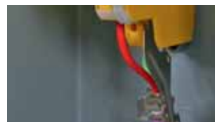
Příslušenstvím jsou pružinové „EMC“ svorky, zajišťující trvalé nízkaimpedanční připojení stínění.
