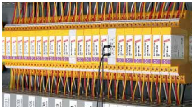
Instalace svodičů BLITZDUCTOR XT s uzemňovacím modulem (šedý). Pomocí testovacího modulu (šedý s kabely) mohou být proměřena připojená vedení bez nutnosti jejich odpojení.
