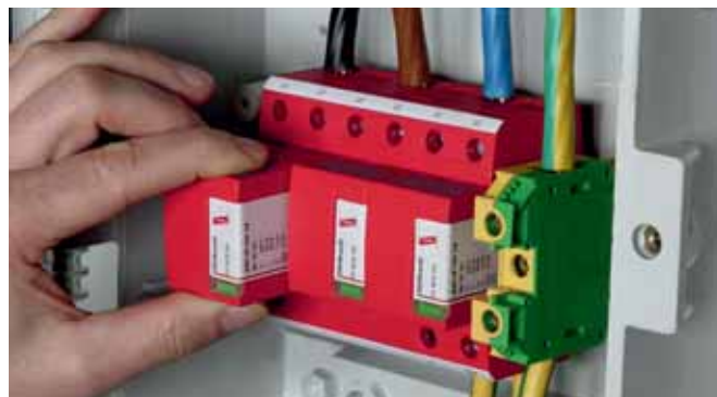
Chrání zařízení a spotřebiče připojené k síti nízkého napětí i při přímých úderech blesku. Instalace na rozhraní zón ochrany před bleskem LPZ 0 A – 2.
