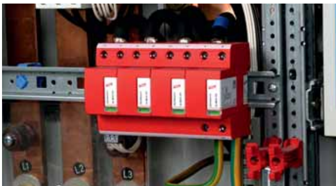
Chrání zařízení a spotřebiče připojené k síti nízkého napětí při přímých úderech blesku. Instalace na rozhraní zón ochrany před bleskem LPZ 0 A – 2.
