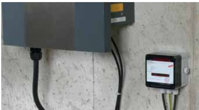
Chrání nízkonapěťová zařízení před přepětím. Instalace podle IEC 60364-7-712 „Instalace fotovoltaických systémů“ (ČSN 33 2000-7-712 Solární fotovoltaické (PV) napájecí systémy).
