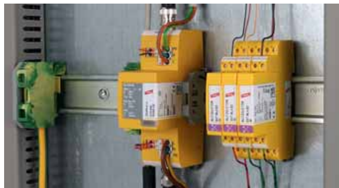
Prostorově a montážně optimalizovaný svodič 3 v 1 DEHNvario chrání analogové videokamery.
