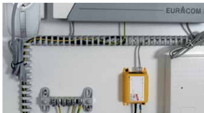
Svodič přepětí s konektory RJ, určený pro montáž na stěnu, chrání koncová telekomunikační zařízení.
