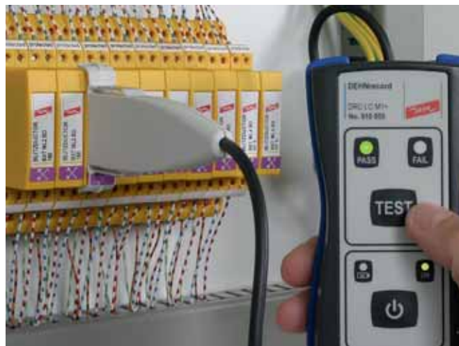
Test modulu svodiče pomocí ručního měřicího přístroje s bezdrátovou technologií.
