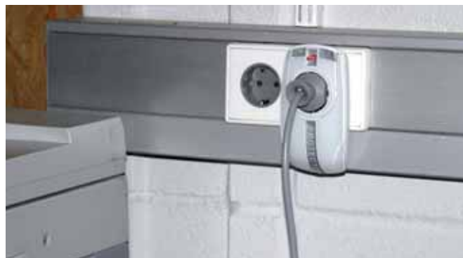
Adaptéry pro ochranu síťového napájení elektronických přístrojů před tranzientním přepětím, stejně jako vysokofrekvenčním rušením (DEHNpro 230 F-Protector). Instalace na rozhraní zón ochrany před bleskem LPZ 1 - 2 a vyšších.
