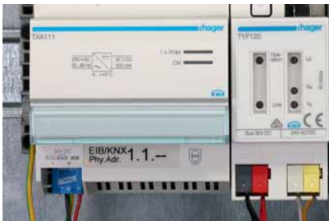
Ochrana napájecí jednotky KNX prostřednictvím svodiče BUSector. Instalace do výstupního BUS slotu.
