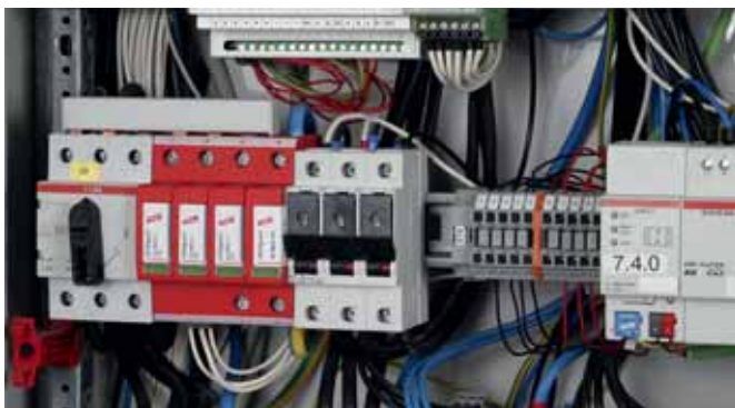
Chrání nízkonapěťová zařízení před přepětím. Instalace na rozhraní zón ochrany před bleskem LPZ 0 B – 1 a vyšších.
