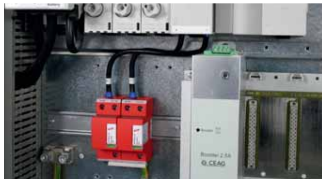
Chrání zařízení a spotřebiče napájené stejnosměrným proudem i při přímých úderech blesku. Instalace na rozhraní zón ochrany před bleskem LPZ 0 A – 1.
