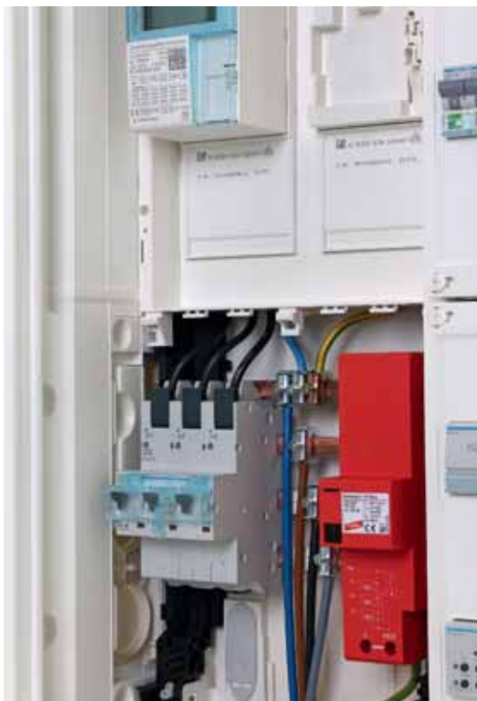
Chrání zařízení a spotřebiče připojené k síti nízkého napětí i při přímých úderech blesku. Instalace na rozhraní zón ochrany před bleskem LPZ 0 A – 2.
