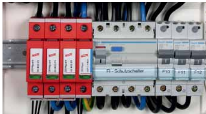
Chrání nízkonapěťová zařízení před přepětím. Instalace na rozhraní zón ochrany před bleskem LPZ 0 B – 1 a vyšších.
