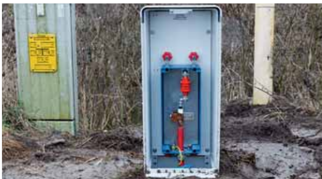
Oddělovací jiskřiště pro výbušné atmosféry (Ex) připojené koaxiálním kabelem; pro podzemní izolační vložky.
