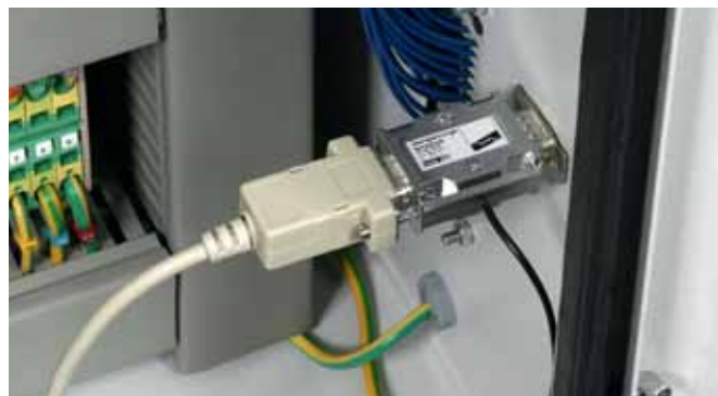
Svodič přepětí řešený jako propojovací adaptér s konektory D-SUB (zdiřka/zástrčka).
