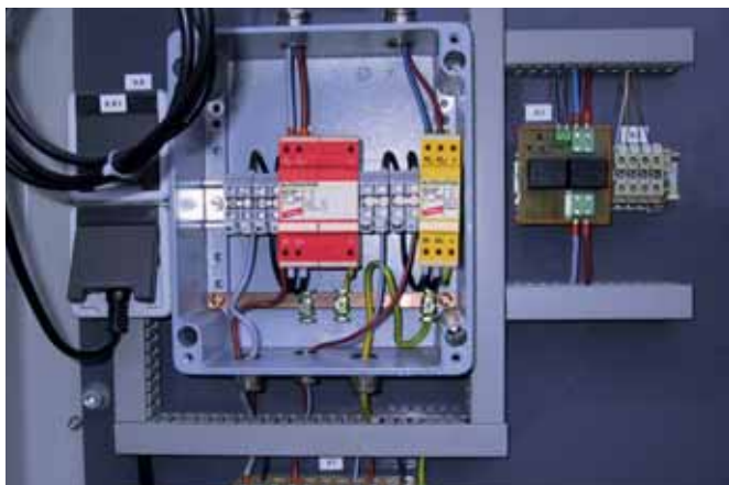
Svodiče pro ochranu zařízení protikorozní katodické ochrany. Svodiče jsou vybaveny bezpotenciálovým kontaktem dálkové signalizace (rozepínací kontakt).
