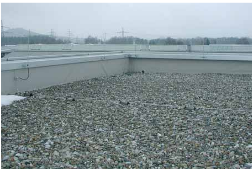
Rys. 1. Przykład instalacji odgromowej na dachu płaskim
