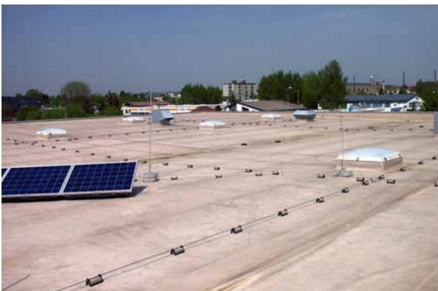
Rys. 2. Przykład instalacji odgromowej na dachu płaskim
