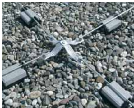
Rys. 10. Zastosowanie elementów elastycznych do łączenia przewodów
