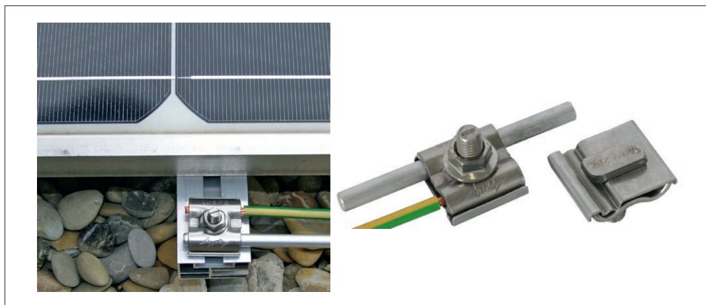
Rys. 5. Połączenia wyrównawcze konstrukcji wsporczej paneli
