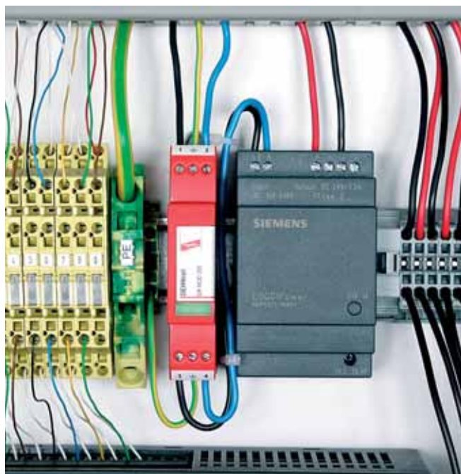
Rys. 6. Przykładowe zastosowanie ogranicznika DEHNrail 255 do ochrony sterownika
