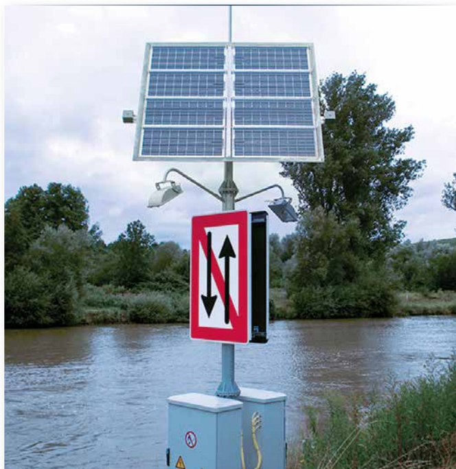
Rys. 1. Autonomiczny układ zasilania instalacji fotowoltaicznej nad brzegiem rzeki
