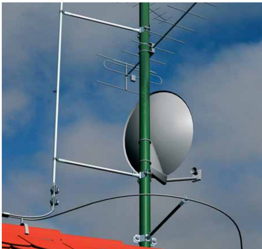
Rys. 5. Zachowanie odstępu izolacyjnego
