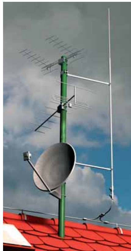
Rys. 1. Zwód pionowy przymocowany do masztu antenowego
