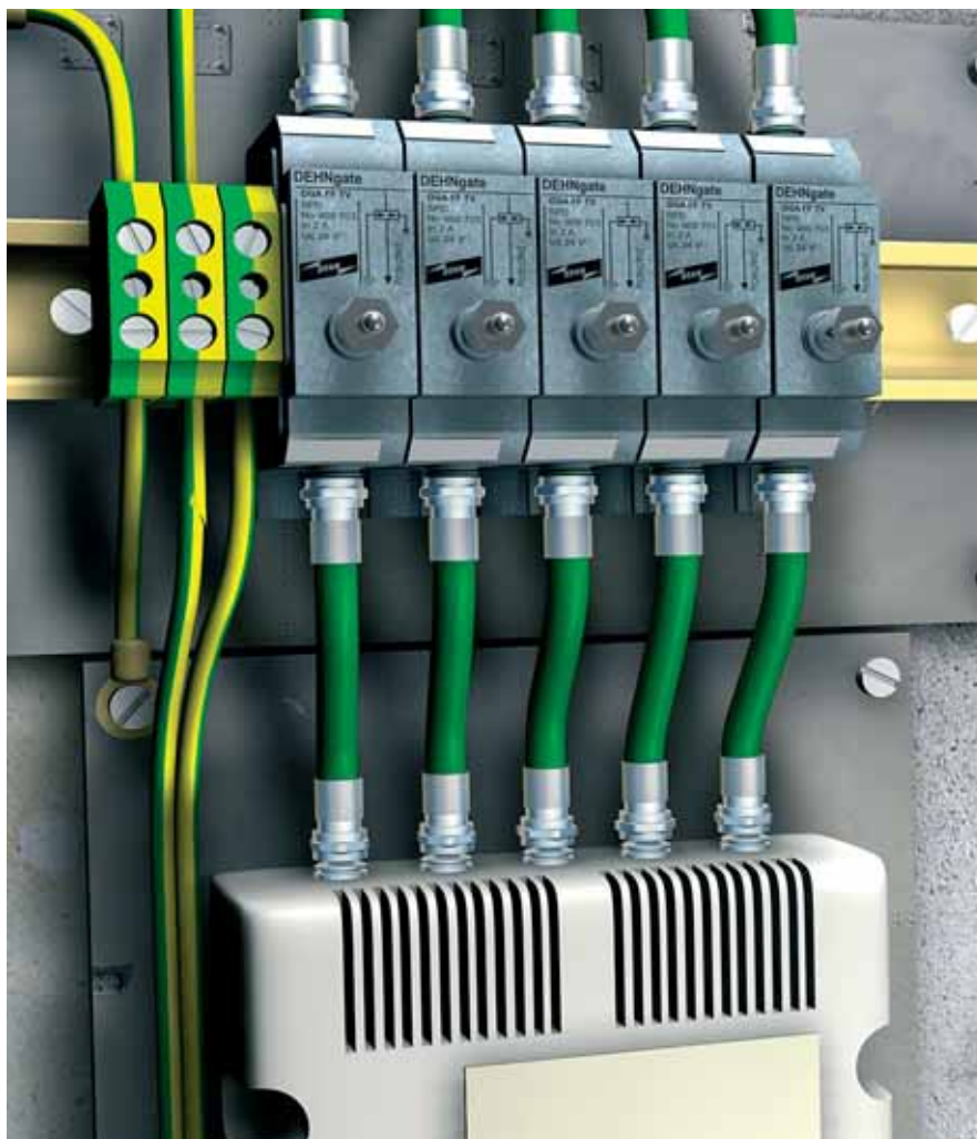
Rys. 6. Zabezpieczenie linii antenowej – wariant 1
