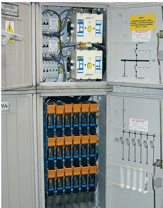
Rys. 2. Rozdzielnie wokół widowni wyposażone w SZR i ochrona przed przebieciami klasy II
