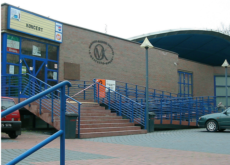
Rys.1. Budynek amfiteatru, wejście główne
