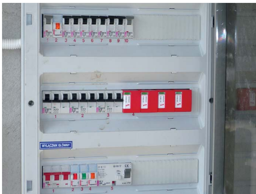
Rys. 2. Zastosowanie ogranicznika DEHNventil w praktyce
