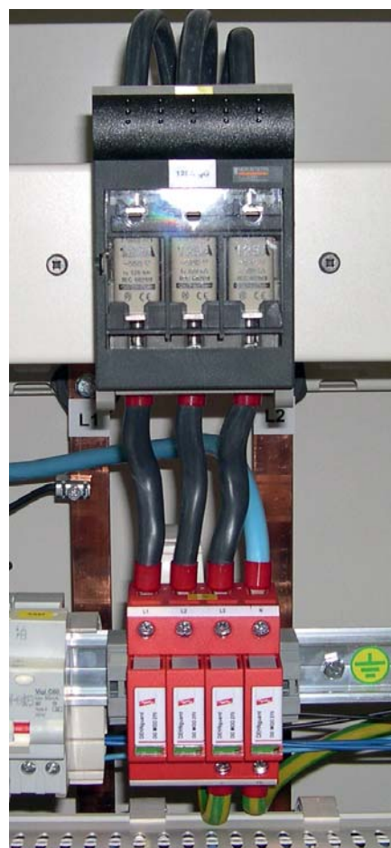
Rys. 2. Przykład dobezpieczenia ogranicznika przepięć typu 2 w rozdzielni
