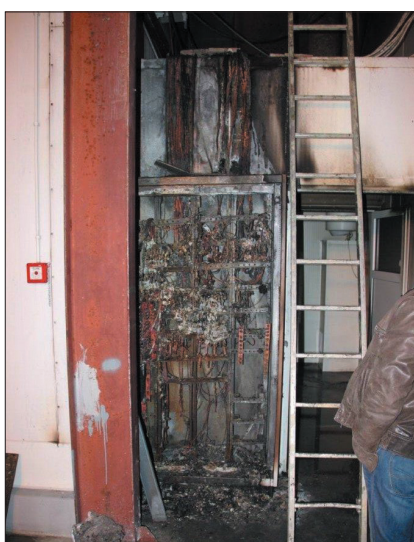
Fot. 2. Uszkodzona rozdzielnica niskiego napięcia z ogranicznikiem „B+C” po przepływie znamionowego prądu impulsowego (Iimp)
