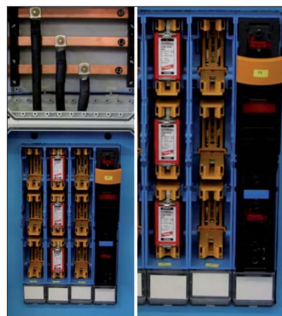
Fot. 3. Montaż ogranicznika VNH w szafie rozdzielczej
