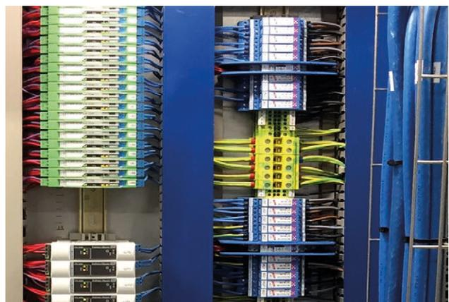
Optimaler Schutz des Steuerungs- und Fernwirksystems mit koordiniertem Überspannungsschutzkonzept
