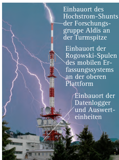
Bild 1. Anordnung der Messeinrichtungen bei den vergleichenden Blitzstrommessungen
