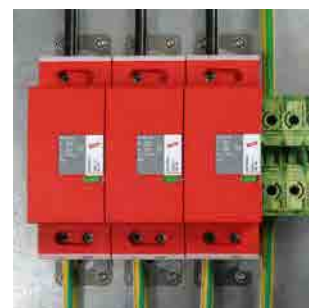
Montaggio flessibile per mezzo di morsetti di montaggio
