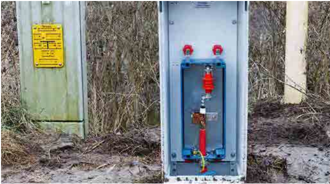
Connessione coassiale dello spinterometro di sezionamento per la protezione di elementi isolanti sotto terra
