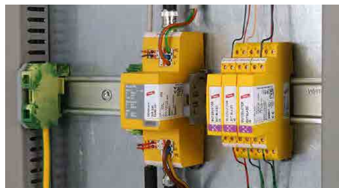
Limitatore 3 in 1 DEHNvario ottimizzato per l'uso e lo spazio per sistemi analogici di telecamere.
