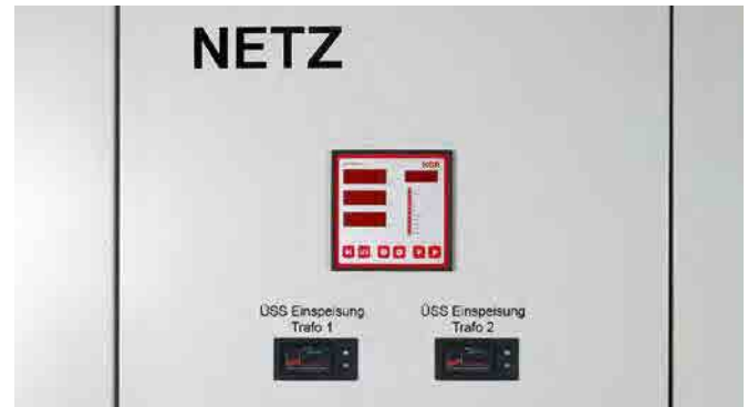
Indicazione ottica per dispositivi di protezione da sovratensioni, per l'installazione in quadri di distribuzione elettrica.
