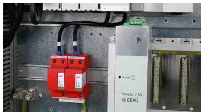
Per la protezione da sovratensioni di impianti elettrici utilizzatori in corrente continua, anche in caso di fulminazione diretta. Per l'impiego nel concetto di protezione da fulminazione a zone, ai passaggi 0 A – 1.
