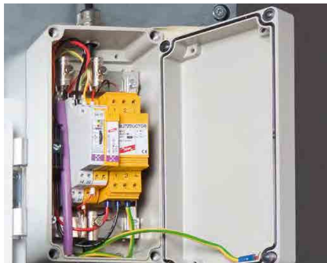
Protezione compatta degli apparecchi, con connessioni tramite morsetti a vite, per conduttori a più fili, con montaggio su guida profilata.
