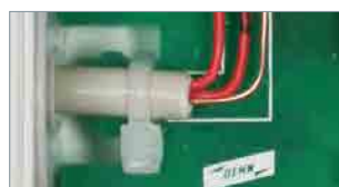
Fissaggio dei cavi tramite fascette (DBX TC 180).
