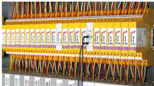
BLITZDUCTOR XT con un modulo di messa a terra (grigio) installati. Con il modulo di prova (grigio con cavi) possono essere effettuate misure sulle linee senza scollegare i fili.
