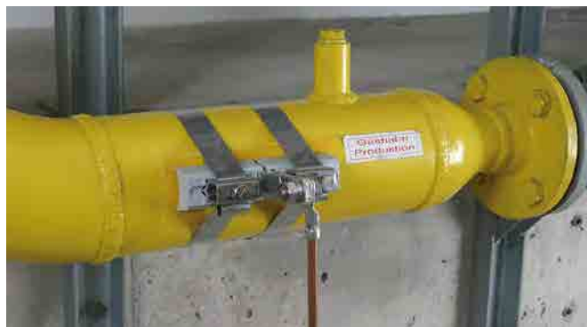
Fascetta di messa a terra per il collegamento elettrico di tubi in ambienti Ex per la realizzazione dell'equipotenzialità antifulmine secondo CEI EN 62305-3 (CEI 81-10/3).
