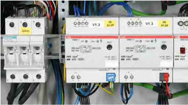
Limitatore di sovratensione per bus EIB / KNX con fili di connessione.
