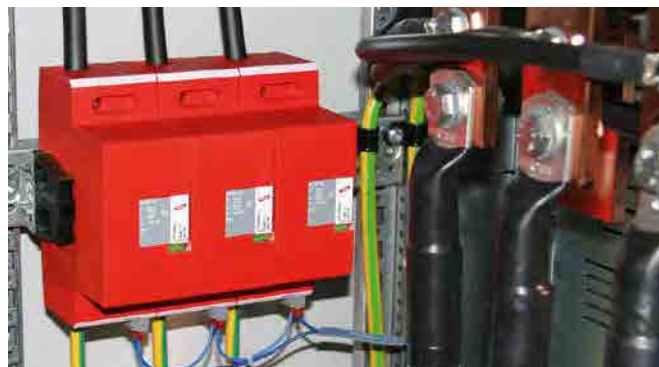
Per la protezione di impianti elettrici utilizzatori in bassa tensione da sovratensione anche in caso di scariche dirette di fulmine. Per l'impiego nel concetto di protezione da fulminazione a zone sulle interfacce O_A - 1 .
