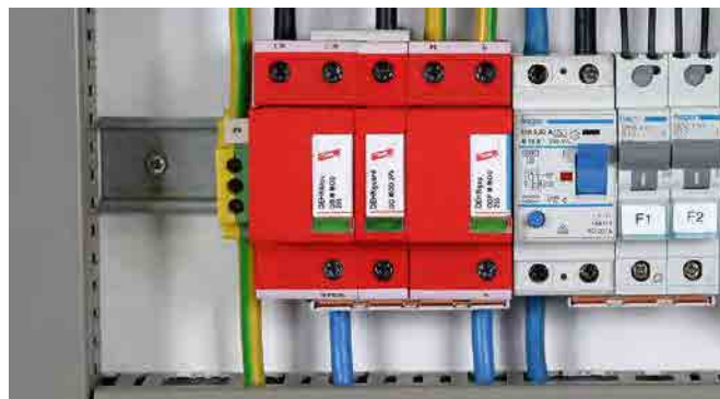
Per la protezione da sovratensioni impianti elettrici utilizzatori in bassa tensione, anche in caso di fulminazione diretta. Per l'impiego nel concetto di protezione da fulminazione a zone, ai passaggi 0_A - 1 , nel circuito "3+1".
