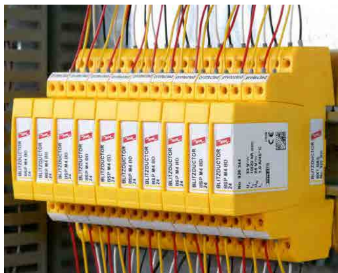
Limitatore di sovratensione multipolare, universale, per sistemi informatici.
