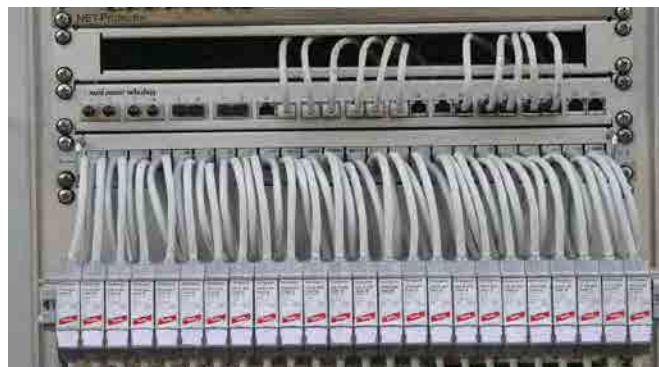
DEHNpatch è il primo cavo patch con protezione da sovratensioni in performance Cat. 6A, che è adatto per l'applicazione fino a 57 V DC secondo IEEE 802.3at.
