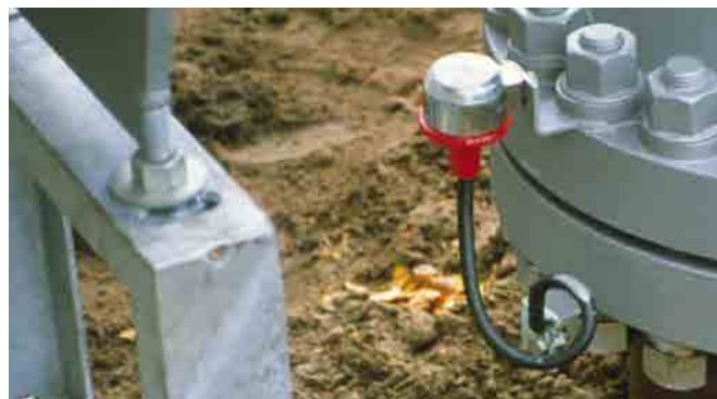
Spinterometri certificati ATEX ed IECEx, per l'equipotenzializzazione antifulmine secondo CEI EN 62305, in esecuzione approvata e collegamento flessibile per conduttori.
