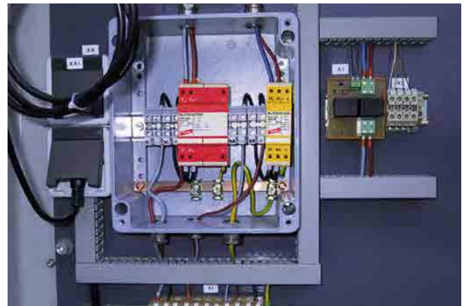
Scaricatore per la protezione di impianti attivi di protezione catodica. Con contatto pulito di telesegnalamento integrato (contatto di riposo / n.c.) per il controllo del funzionamento.
