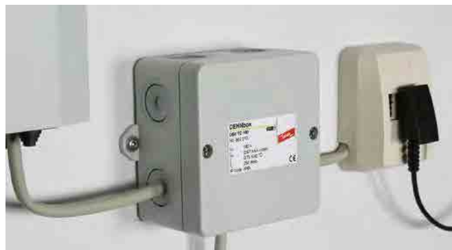
DEHNbox nel punto di connessione di un impianto telefonico (esempio: interfaccia U k0 )
