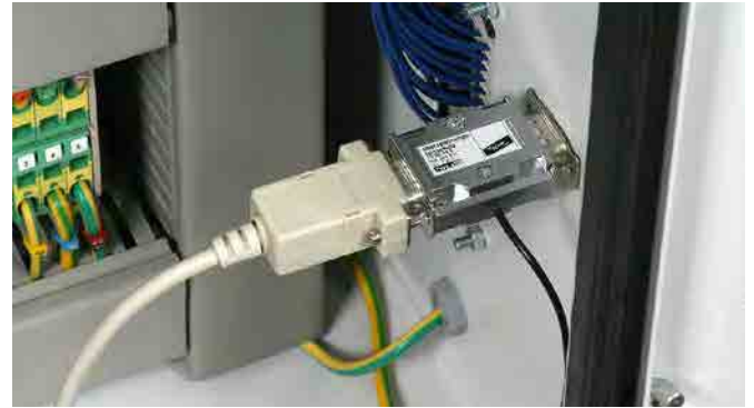
Adattatore di protezione da sovratensioni per connessione D-subminiaturizzato in esecuzione maschio-femmina.
