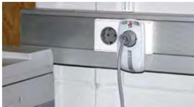
Adaptergeräte zum Schutz der Netzversorgung von elektronischen Geräten vor transienten Überspannungen sowie hochfrequenten Störspannungen (DEHNpro 230 F-Protector). Zum Einsatz im Blitz-Schutzzonen-Konzept an Schnittstellen 1 – 2 und höher.
