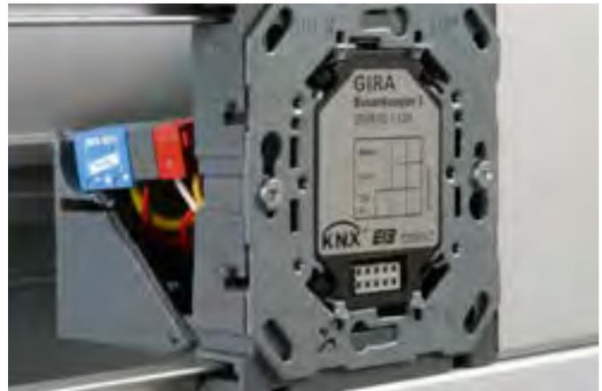
Schutz eines KNX-Busankopplers mit dem BUSstector. Installation an einer Busklemme im Montageaum eines Kabelkanals.
