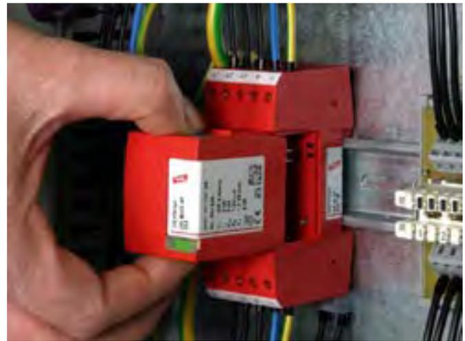
Zum Schutz der Netzversorgung von Geräten der Industrieelektronik vor transienten Überspannungen in Schaltschränken. Zum Einsatz im Blitz-Schutzzonen-Konzept an Schnittstellen 1 – 2 und höher.
