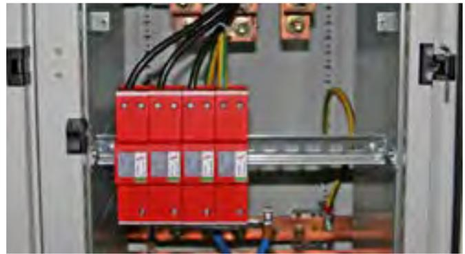
Zum Schutz von Niederspannungs-Verbraucheranlagen vor Überspannungen auch bei direkten Blitzeinschlägen. Zum Einsatz im Blitz-Schutzkonzept an den Schnittstellen 0A – 1.
