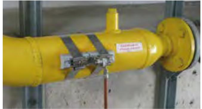
Bandrohrschelle zur elektrischen Kontaktierung von Rohren im Ex-Bereich, zur Umsetzung des Blitzschutz-Potentialausgleichs nach DIN EN 62305-3 (VDE 0185-305-3).
