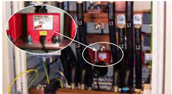
Zum Schutz von Niederspannungs-Verbraucheranlagen vor Überspannungen auch bei direkten Blitzschlägen. Zum Einsatz im Blitz-Schutzzonen-Konzept an Schnittstellen  $0_A - 1$ .
