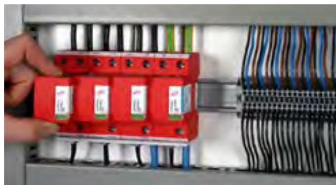
Zum Schutz von Niederspannungs-Verbraucheranlagen vor Überspannungen, auch bei direkten Blitzschlägen. Einsetzbar nach dem Blitz-Schutzzonen-Konzept an den Schnittstellen  $O_A - 1$ .
