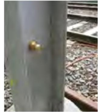
In DIN EN 50122-1 wird für Gleichstrom- und Wechselstrombahnen der Einsatz von Spannungsbegrenzungseinrichtungen für die sogenannte „offene Bahnerdung“ von leitfähigen Bauteilen im Oberleitungs- und Stromabnehmer-Bereich beschrieben.
