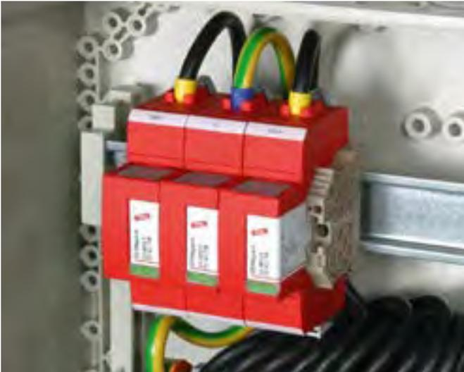
Zum Schutz von Niederspannungs-Verbraucheranlagen vor Überspannungen. Zum Einsatz gemäß IEC 60364-7-712: "Errichten von Photovoltaik-Versorgungssystemen".
