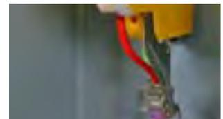
EMV-Federklemme als Zubehör für dauerhafte, niederimpedante Schirmkontaktierung.
