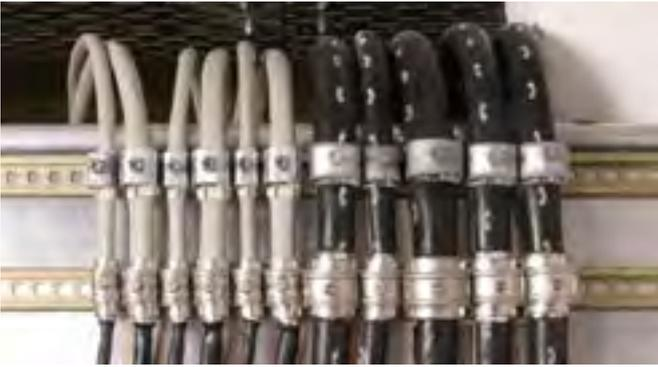
Blitzstromtragfähiges Schirmanschlusssystem für die Ankerschiene, Kompensation des Fließverhaltens der eingesetzten Kabelwerkstoffe durch nachsetzendes Federelement.
