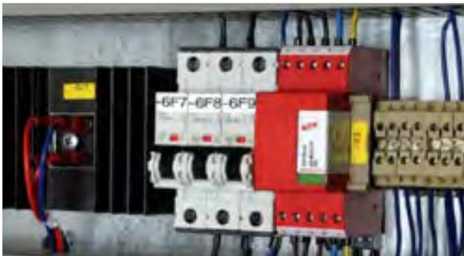
Zum Schutz der Netzversorgung von Geräten der Industrieelektronik vor transienten Überspannungen in Schaltschränken. Zum Einsatz im Blitz-Schutzkonzept an Schnittstellen 1 – 2 und höher.
