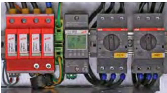
Zählgerät mit LCD-Anzeige und eingebauter Batterieversorgung (3 V). Anzeige des Batteriestatus, Anzahl der Blitzereignisse mit Datum und Uhrzeit.
