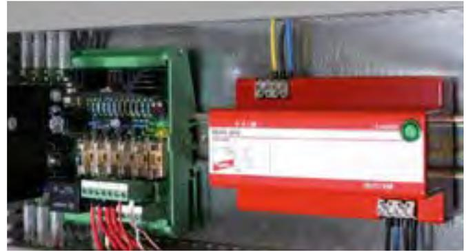
Zum Schutz der Netzversorgung von Geräten der Industrieelektronik (z. B. speicherprogrammierbare Steuerung/SPS) vor transienten Überspannungen und hochfrequenten Störspannungen. Zum Einsatz im Blitz-Schutzkonzept an Schnittstellen 1 – 2 und höher.
