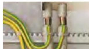
Die Schirme eingeführter Leitungen lassen sich mit Kontaktrollfedern SA KRF platzsparend und blitzstromtragfähig kontaktieren.
