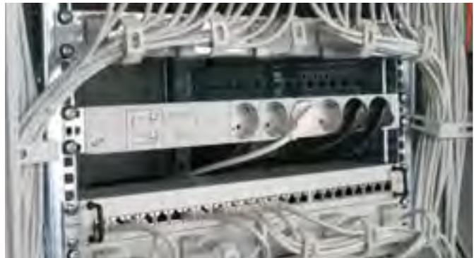
Die verwechslungssichere Y-Schutzbeschaltung berücksichtigt die fehlende Zuordnung von Phase und Neutraleiter in handelsüblichen Schutzkontakt-Steckdosen. Die standardmäßigen grünen und roten Leuchtanzeigen signalisieren dem Anwender auf einen Blick den Betriebszustand des Überspannungs-Schutzgerätes.
