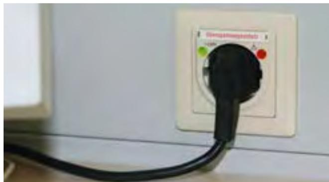
Zum Schutz von elektronischen Geräten vor Überspannungen. Schutzkontakt-Steckdose mit Überspannungsschutzbeschaltung zum Einbau in Elektroinstallationsysteme. Zum Einsatz im Blitz-Schutzkonzept an Schnittstellen 1 – 2 und höher. DE-Gebrauchsmuster.
