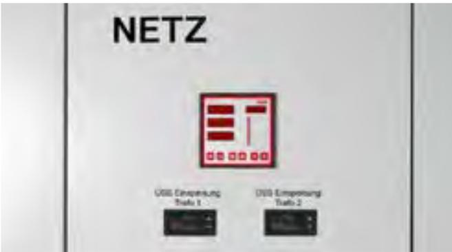
Optische Anzeige für Überspannungs-Schutzgeräte zum Schaltschrankbau.
