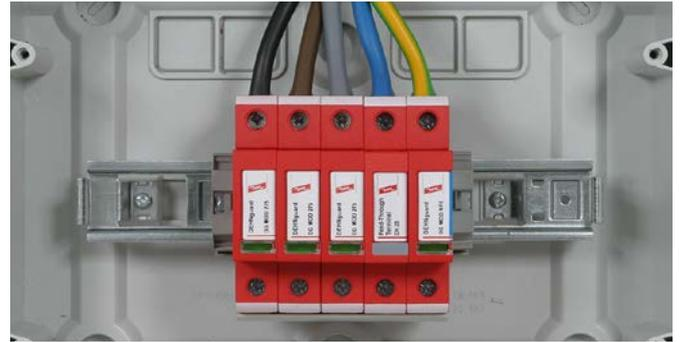
Einheitliche Verdrahtungsebene von oben durch die Verwendung der Durchgangsklemme DK 25.
