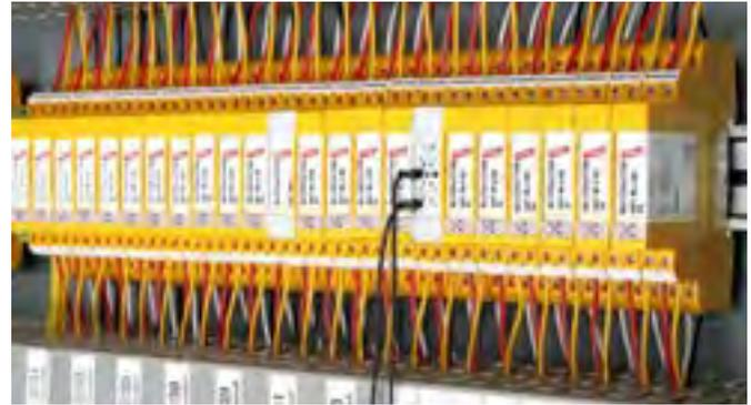
BLITZDUCTOR XT mit einem Erdungsmodul (grau) in der Installation verbaut. Mit dem Messmodul (grau mit Strippen) können ohne das Auftrennen der Klemmen die Leitungen durchgemessen werden.
