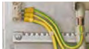
Am zentralen Erdungsblock werden alle Potentialausgleichsleitungen zusammengesgeschlossen.
