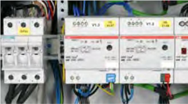
Überspannungs-Ableiter für den KNX/EIB-Bus mit Anschlussdrähten.
