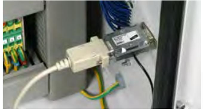
Überspannungs-Ableiter, D-SUB-Steckanschluss in Stecker-Buchse-Ausführung.
