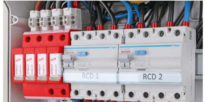
EMV-optimale V-Verdrahtung bei Stringleitungen in einem PV-Generatoranschlusskasten mittels STAK 3X16.
