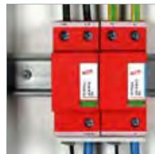
Die betriebsstromfreie Funktions- / Defektanzeige des DEHNbloc M gibt sofort Auskunft über die Betriebsbereitschaft des Gerätes. Neben der standardmäßigen Sichtanzeige mit grün-roter Farbmarkierung stehen dem Anwender mit den Gerätevarianten DEHNbloc M... FM Geräte mit zusätzlichem Fernmeldeaussgang zur Verfügung. Durch die Ausführung des Fernmeldekontaktes als potentialfreier Wechsler kann, je nach Schaltungskonzept, das Fernsignalisierungssignal als Öffner oder Schließer verwendet werden.
