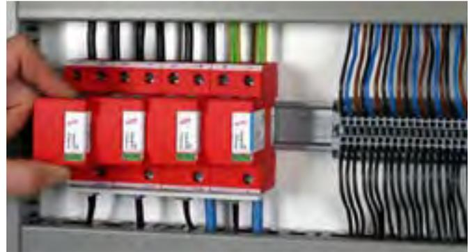
Zum Schutz von Niederspannungs-Verbraucheranlagen vor Überspannungen, auch bei direkten Blitzeinschlägen. Einsetzbar nach dem Blitz-Schutzzonen-Konzept an den Schnittstellen  $0_A - 1$  in der 3+1-Schaltungsvariante.
