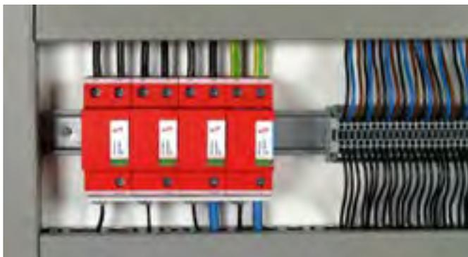
Zum Schutz von Niederspannungs-Verbraucheranlagen vor Überspannungen auch bei direkten Blitzeinschlägen. Zum Einsatz im Blitz-Schutzzonen-Konzept an den Schnittstellen  $O_A - 1$ .
