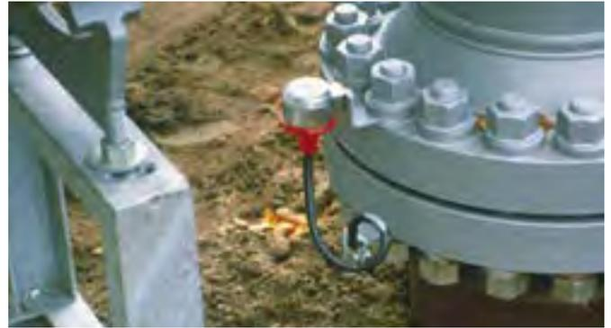
ATEX- und IECEx-zertifizierte Trennfunkensrecke für den Blitzschutz-Potentialausgleich nach DIN EN 62305 / VDE 0185 in bewährter Ausführung mit flexiblem Leiteranschluss.
