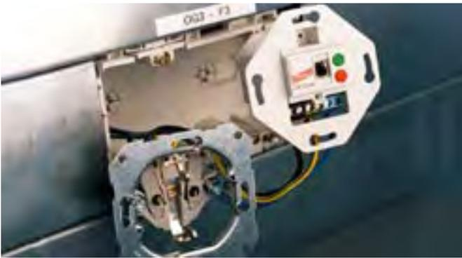
Zum Schutz elektronischer Geräte vor Überspannungen. Zum Einbau in Elektroinstallationsysteme, wie z. B. Kabelkanäle und Geräteeinbaudosen. Zum Einsatz im Blitz-Schutzzonen-Konzept an Schnittstellen 1 – 2 und höher.
