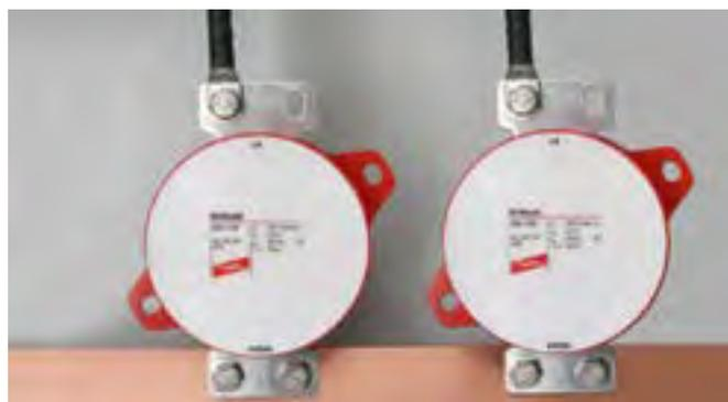
Zum Schutz von Niederspannungs-Verbraucheranlagen vor Überspannungen auch bei direkten Blitzeinschlägen. Zum Einsatz im Blitz-Schutzzonen-Konzept an Schnittstellen  $0_A - 1$ .
