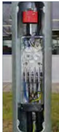
LED-Leuchten werden mit der DEHNcord-Familie optimal gegen Überspannungen geschützt. Zur Integration im Sicherungskasten eignet sich die LTG Variante. Durch die angepasste Bauform passt das Produkt ideal in den oberen Kabelanschlussbereich des Kabelübergangskastens EK480 der Firma Langmatz.
