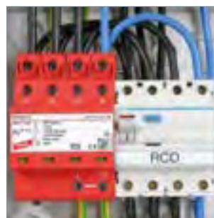
V-Verdrahtung mit blitzstromgeprüfter Stiftanschlussklemme STAK 25.
