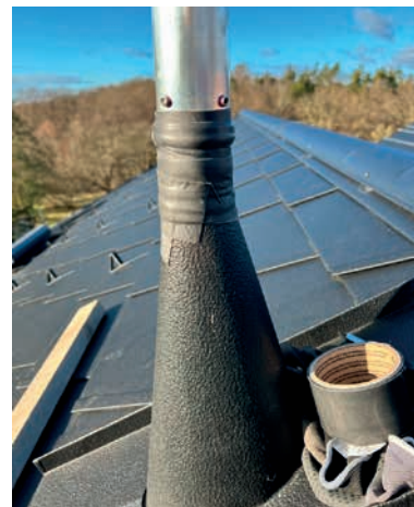
Obr. 8. Detail hotového prostupu
