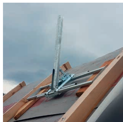
Obr. 6. Nainstalovaný držák mezi krokve
