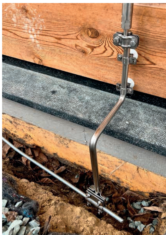
Obr. 12. Detail hotového napojení svodu na uzemnění
