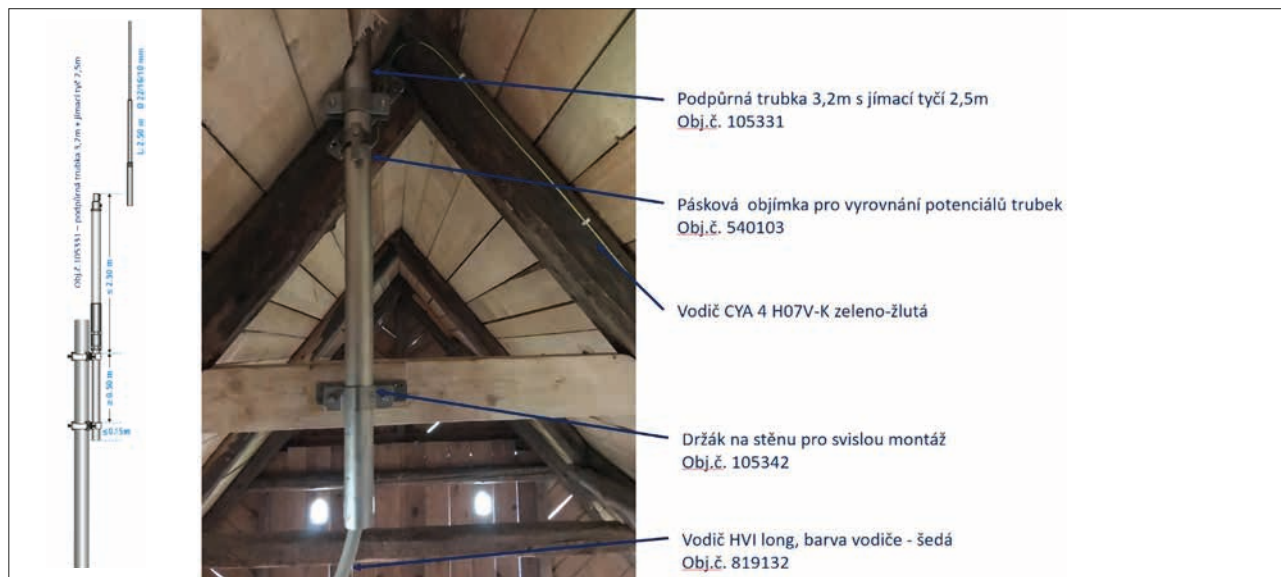
Obr. 2. Ukázka kotvení podpůrné trubky ke krovu stavby
