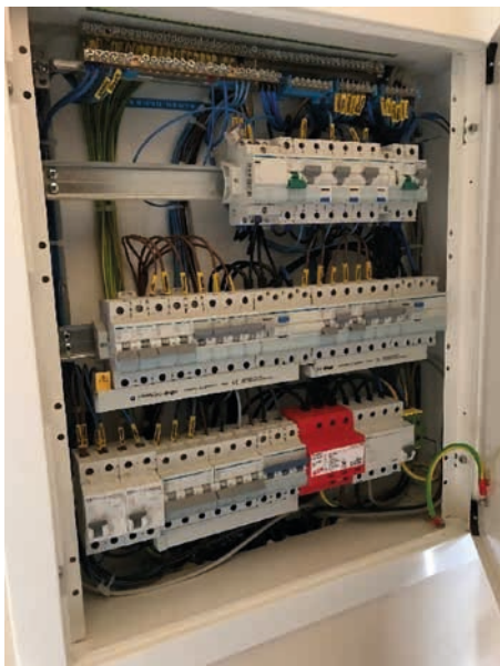
Obr. 13. Vnitřní ochrana proti přepětí, instalován DEHNshield TNC
