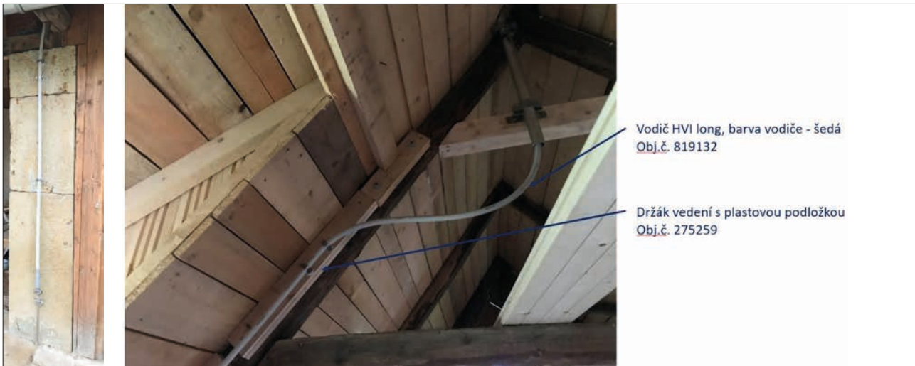
Obr. 7. Kotvení vodiče HVI long pod střešní krytinou a na stěně objektu
