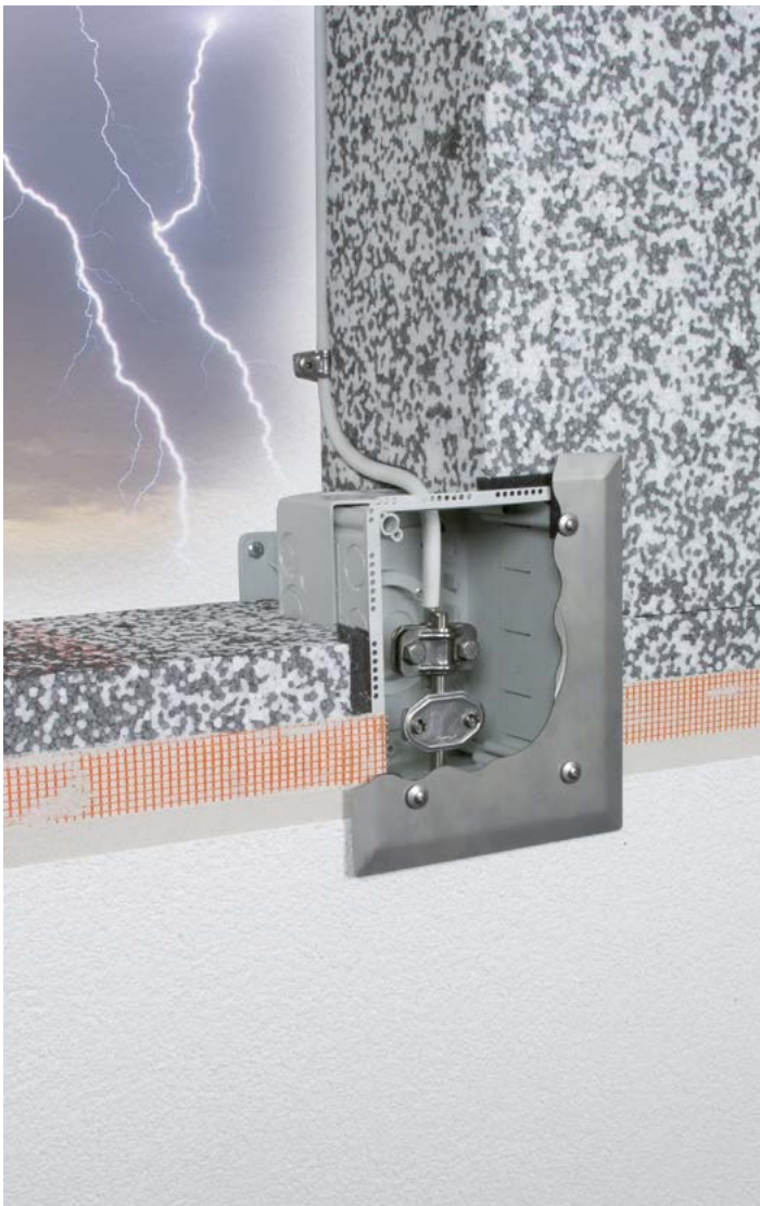
Einbau des Trennstellenkastens in den Vollwärmeschutz
