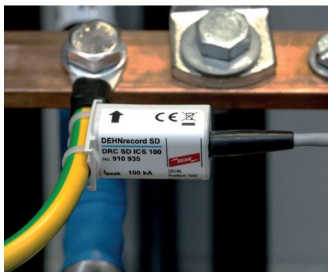
Rys. 4. Czujnik zewnętrzny do rejestracji uderzeń prądowych Fig. 4. External sensor for recording current surges
