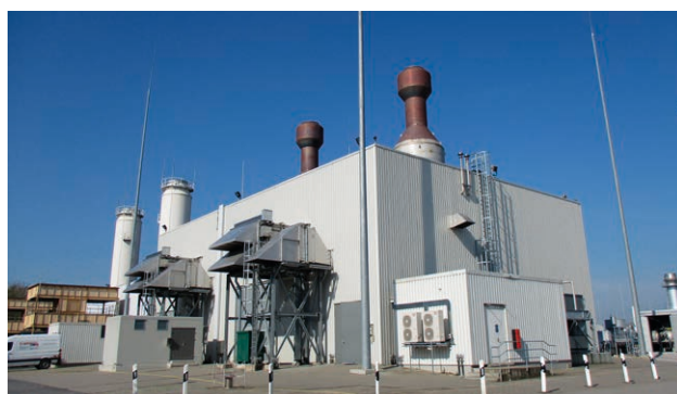
Bilder: Getrenntes äußeres Blitzschutzsystem mit HVI-Installation an der Verdichterstation Werne
