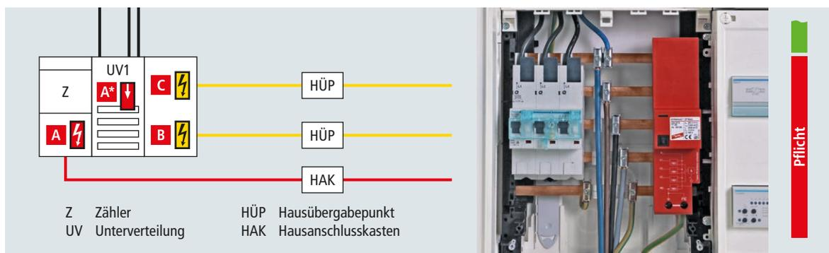
Bild 3 Einsatz Kombiableiter DEHNshield ZP basic im Vorzählerbereich, Ableiter für Kommunikationsleitungen im Multimediafeld
