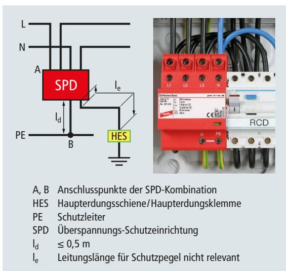
Bild 8 V-Verdrahtung mit DEHNshield Basic
