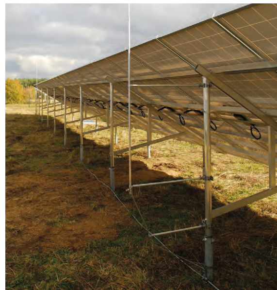
2. ábra: DEHN-iso távtartókkal szerelt villámvédelem
